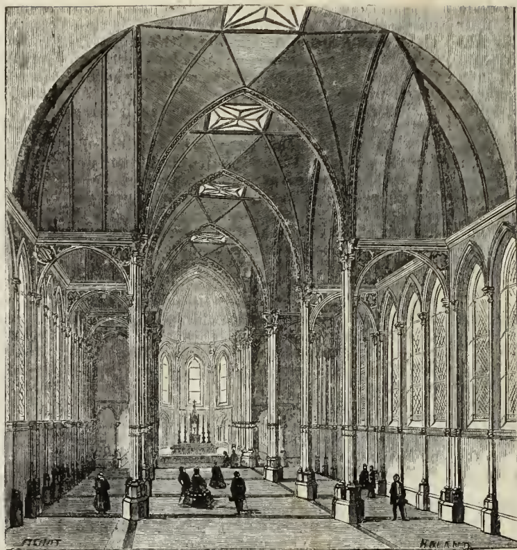
INTERNO D'UNA CHIESA DI FERRO.
